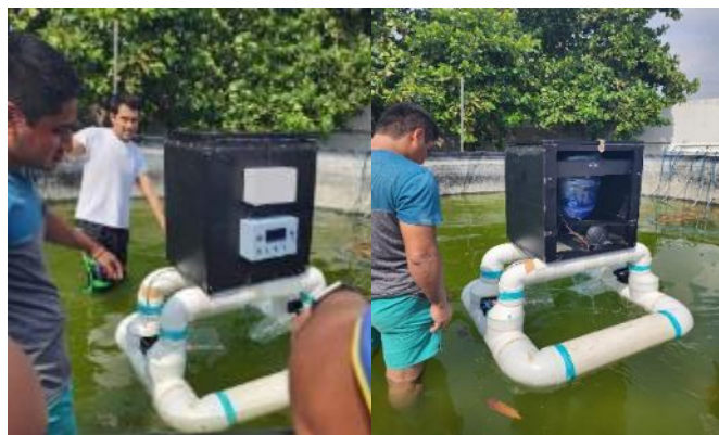
Fig. 13 Instalación del sistema en la geomembrana del área de acuicultura del ITSAL
